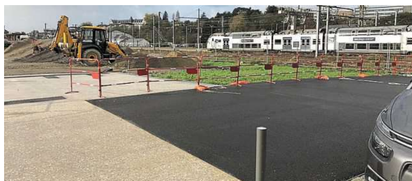
Près de 1 000 tonnes de matériaux vont être réutilisées dans le projet du pôle d'échanges multimodal de la gare. PHOTO : OUEST-FRANCE
